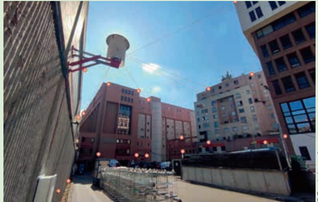
Installation prisme pour une station totale.
