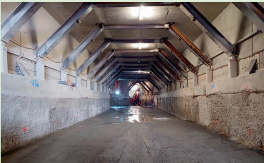
Vue sur la galerie et les travaux de soutènement.
